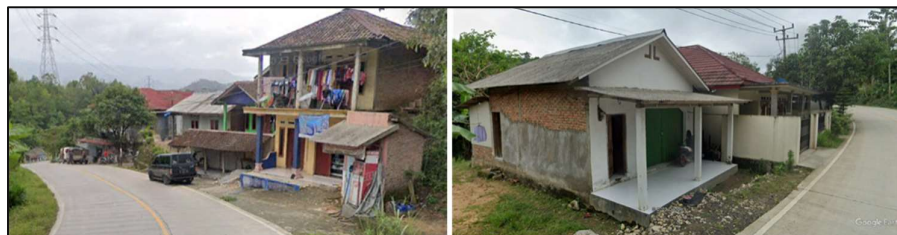
Berdasarkan pengamatan di lapangan yang berkenaan dengan kualitas fisik dan konstruksi rumah diketahui bahwa sebagian besar rumah penduduk disekitar kuari PT LEN terbangun dari tembok yang mempunyai fondasi batu belah, tiang (kolom) dan balok horizontal penghubung setiap tiang. Dinding bangunannya terbuat dari susunan bata sepenuhnya dan diplester, namun ada pula yang hanya separuh dinding tersusun dari bata diplester dan separuhnya lagi tersusun dari papan. Umumnya fondasi rumah terbuat dari bongkah batu belah yang direkat semen, sedangkan kolom balok terbuat dari cor semen dan besi (Gambar 5). Dengan demikian bangunan rumah di sekitar kuari PT LEN dapat dikategorikan sebagai bangunan kelas 3.
